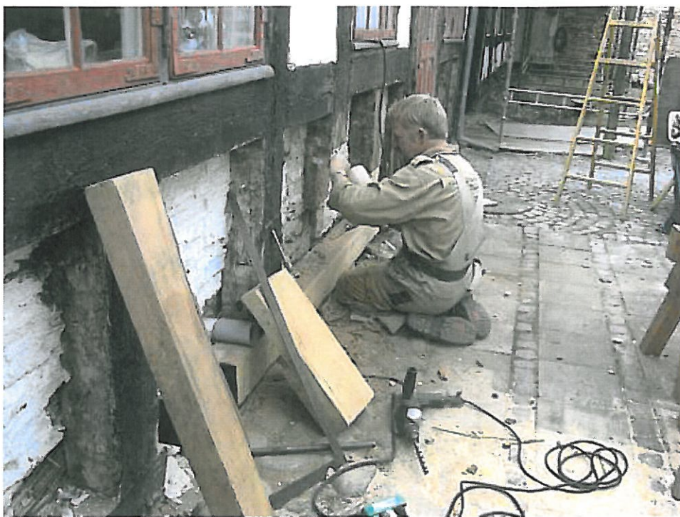
■ Jens Led fra Tømrer/Snedkerfirma Henning Hansen i Hjørte ved Gelsted på Fyn har specialiseret sig i at arbejde med bindingsværk efter de gamle teknikker og arbejder i disse dage på renoveringen af den fredede Gammelgaard i Husby.
