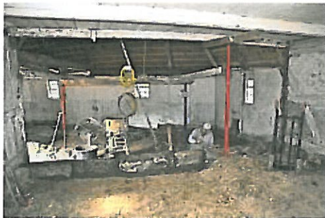
■ Sokkelstenen af granit reparerer.
